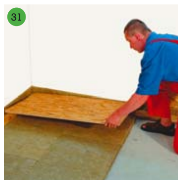
Pokládka první roznášecí vrstvy deskou OSB SUPERFINISH®
