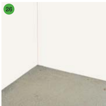
Příprava rovného podkladu je naprosto nezbytná
