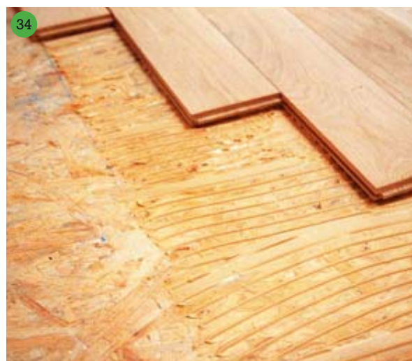
Plošné lepení dřevěné podlahy
