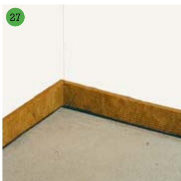
Osazení dilatačního pásku Steprock
