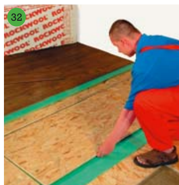
Pokládka druhé roznášecí vrstvy (kolmo k první) deskou OSB SUPERFINISH®
