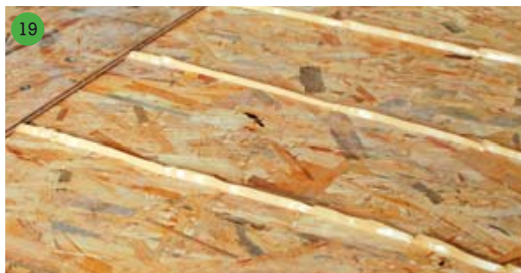
„Housenky“ lepidla pro slepení 2 vrstev OSB desek
