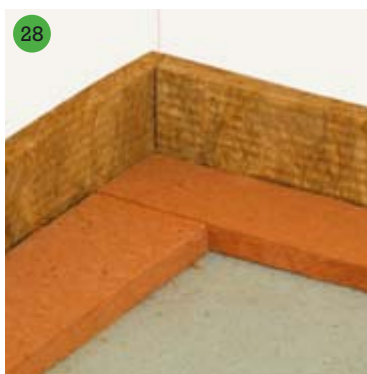
Položení spodní části okrajového pásku (Steico standard apod.)
